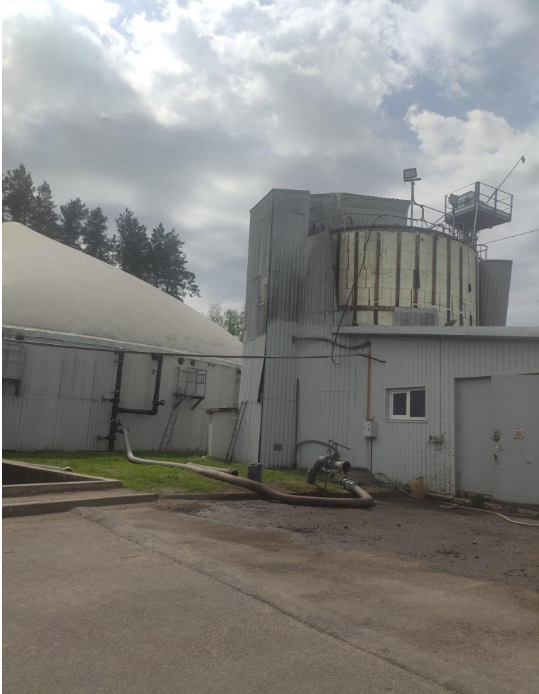
Біогазові установки для анаеробної ферментації (мезофільний процес, тривалість 30-40 діб)
